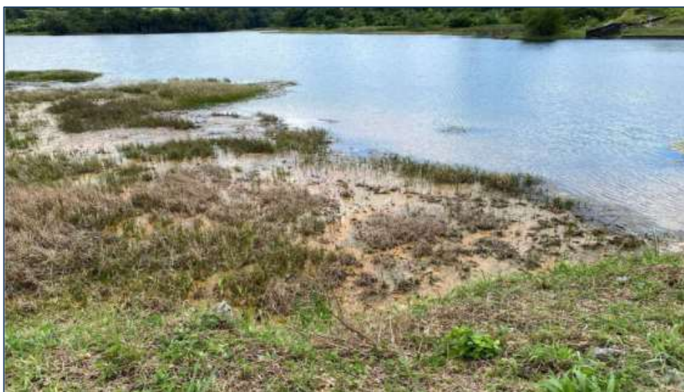
Figura 75: Registros fotográficos concernentes ao assoreamento da Barragem da Coréia
