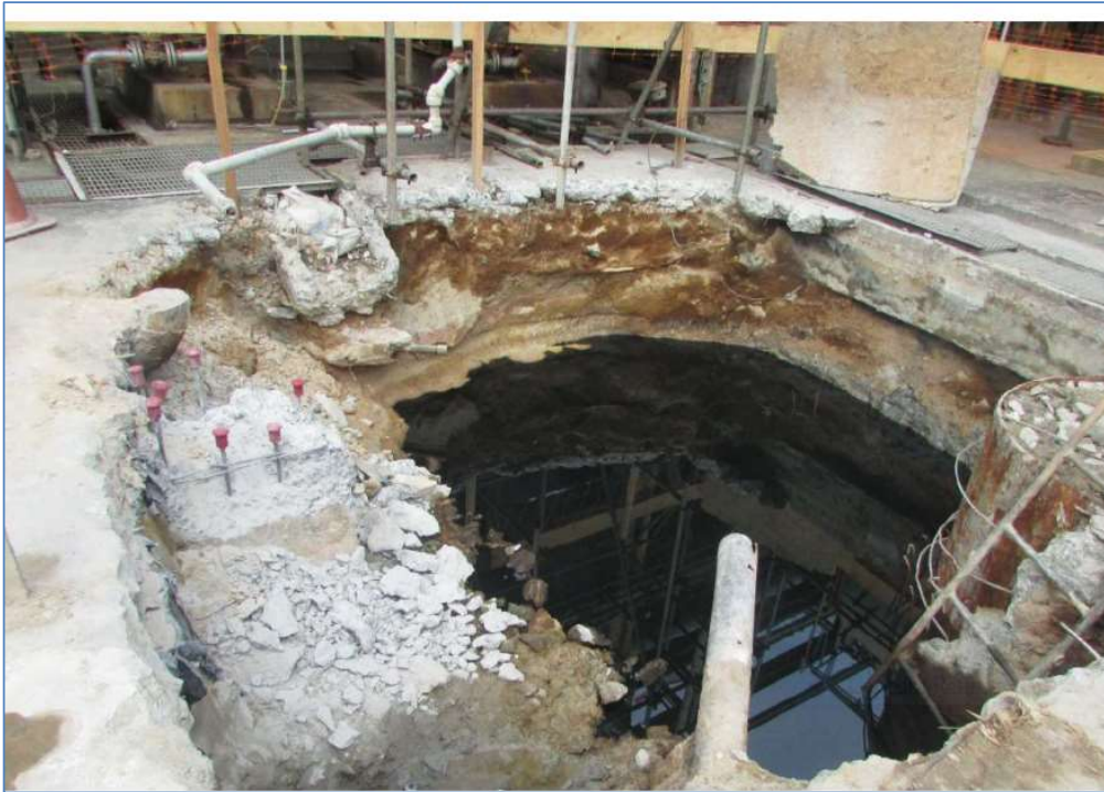
Figura 29: Registro fotográfico extraído de imagens pertinentes à realização de obra civil realizada na Unidade de Craqueamento Catalítico Fluido (U6), a partir do mês de setembro de 2021
