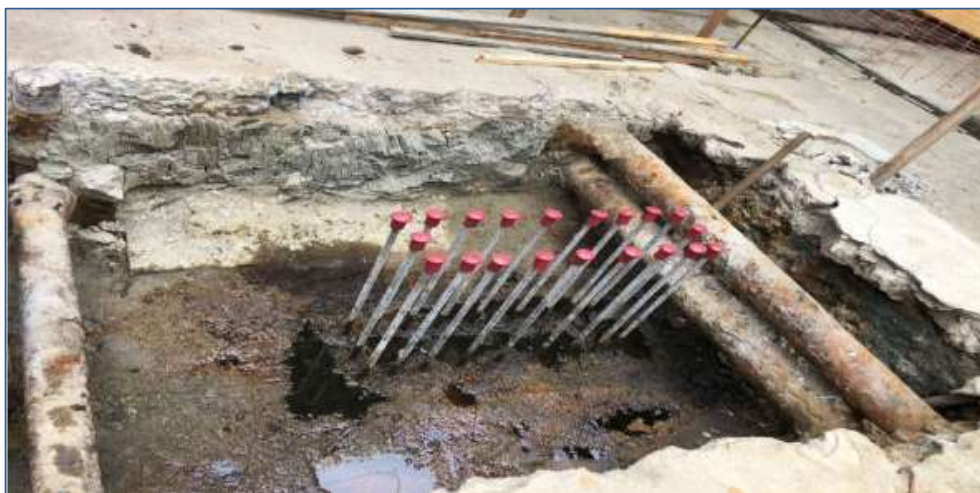
Figura 28: Registro fotográfico extraído de imagens pertinentes à realização de obra civil realizada na Unidade de Craqueamento Catalítico Fluido (U6), a partir do mês de setembro de 2021
