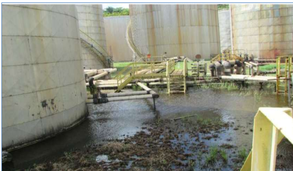
Figura 49: Registro fotográfico da área interna da FASF, a evidenciar a precariedade das estruturas dos tanques, abandonados pela RLAM - tal como a precariedade da pavimentação existente na base destes equipamentos, a ensejar o acúmulo de água pluvial e a consequente contaminação do solo
