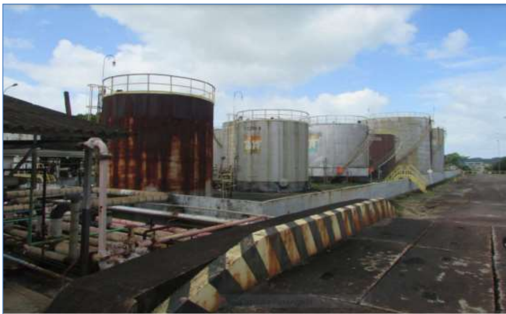
Figura 48: Registro fotográfico da área interna da FASF, a evidenciar a precariedade estrutural dos tanques abandonados pela RLAM, além da evidente contaminação do solo
