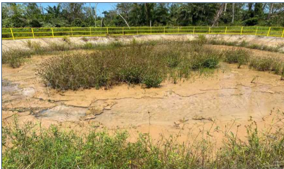
Figura 74: Registros fotográficos concernentes ao assoreamento da Barragem da Coréia
