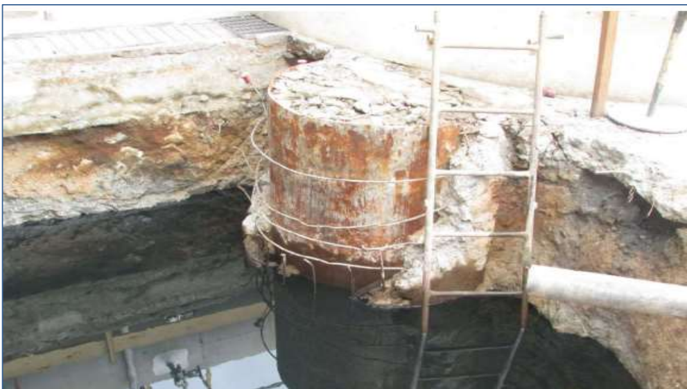
Figura 30: Registro fotográfico extraído de imagens pertinentes à realização de obra civil realizada na Unidade de Craqueamento Catalítico Fluido (U6), a partir do mês de setembro de 2021
