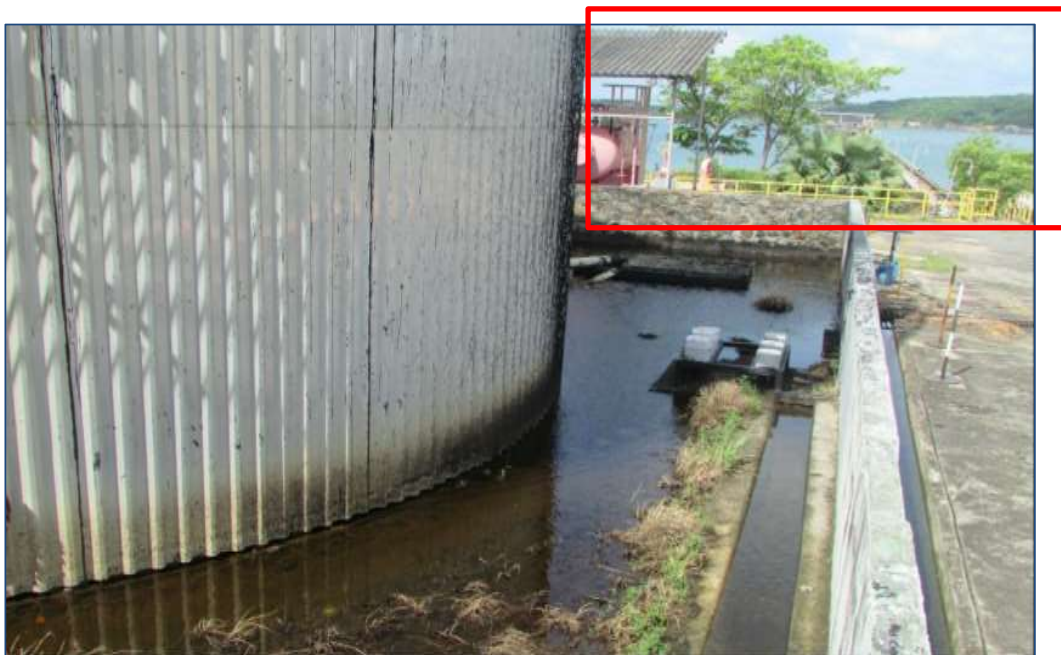
Figura 50: Registro fotográfico da área interna da FASF, a evidenciar a precariedade das estruturas dos tanques, abandonados –pela RLAM - tal como a precariedade da pavimentação existente na base destes equipamentos, a ensejar o acúmulo de água pluvial e a consequente contaminação do solo –, em contrapartida à proximidade do mar
